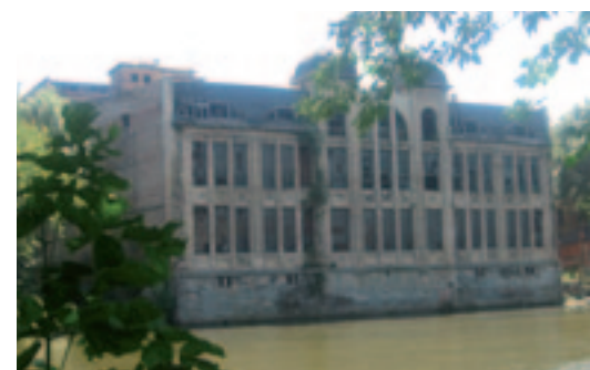
oben: altes Gasometer unten: Jugendstilfassade der ehemaligen Freybergischen Brauerei, Glauchaer Straße, altstadtnah am linken Saaleufer; größte Privatbrauerei Mitteleuropas zu Beginn des 20. Jahrhunderts
